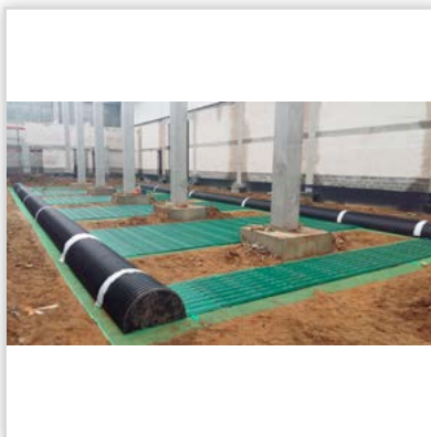
Gruntowy wymiennik ciepła GEOSTRONG – w fundamentach hali
