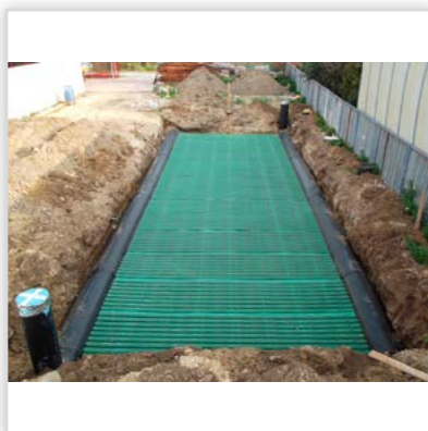
Gruntowy wymiennik ciepła GEOSTRONG – dla hali produkcyjnej. GWC bezprzeprowony modułowy. Przepływ powietrza turbulentny, wymiana cieplna ze wszystkich stron GWC. Wytrzymałość na nacisk z góry: 460 t/m 2 . Zastosowanie: w wentylacji mechanicznej we współpracy z rekuperatorem w obiektach użyteczności publicznej, pawilonach, magazynach, restauracjach. Możliwość wykonania GWC o każdej wielkości przepływu powietrza. Możliwość samodzielnego montażu.
