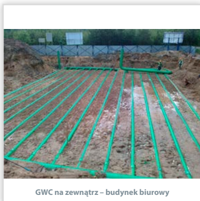
Gruntowy wymiennik ciepła GLOBAL. Wykonany z polietylenu (PE) z warstwą antybakteryjną, antygrzybiczną i antywirusową łączony poprzez zgrzewanie doczołowe lub elektrooporowe, 100% szczelność. Współczynnik przewodzenia [W/mK]: 0,50. Zastosowanie: w wentylacji mechanicznej we współpracy z rekuperatorem obiektach użyteczności publicznej, pawilonach, halach, itp. Możliwość wykonania GWC o każdej wielkości przepływu powietrza.
