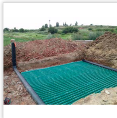
Gruntowy wymiennik ciepła GEOSTRONG – na zewnątrz domu. GWC bezprzeprowony modułowy. Przepływ powietrza turbulentny, wymiana cieplna ze wszystkich stron GWC. Wytrzymałość na nacisk z góry: 460 t/m 2 . Zastosowanie: w wentylacji mechanicznej we współpracy z rekuperatorem w domach jednorodzinnych, wielorodzinnych. Możliwość wykonania GWC o każdej wielkości przepływu powietrza. Możliwość samodzielnego montażu.
