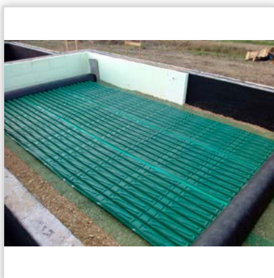
Gruntowy wymiennik ciepła GEOSTRONG – w fundamentach. GWC bezprzeprowony modułowy. Przepływ powietrza turbulentny, wymiana cieplna ze wszystkich stron GWC. Wytrzymałość na nacisk z góry: 460 t/m 2 . Zastosowanie: w wentylacji mechanicznej we współpracy z rekuperatorem w domach jednorodzinnych, wielorodzinnych i przemysle. Możliwość wykonania GWC o każdej wielkości przepływu powietrza. Możliwość samodzielnego montażu.
